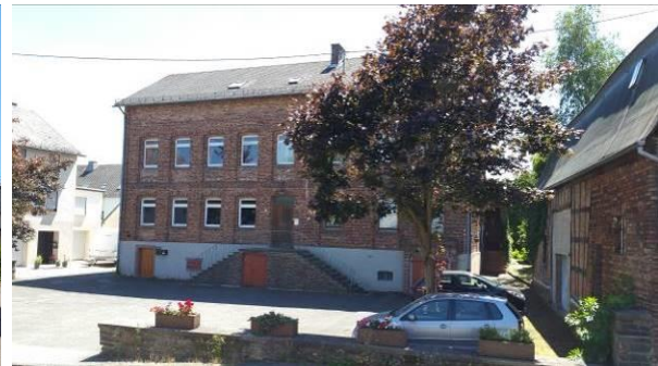
„Alte Schule“, Pfalzfelder Straße
