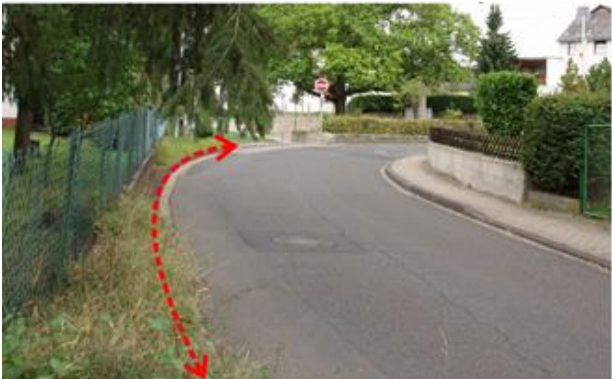
Darstellung fehlender Gehweg „Pfalzfelder Straße“
